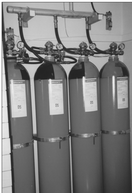
Foto 16. Gaasikustutussüsteemi balloonid Eesti Ajaloomuuseumis.
